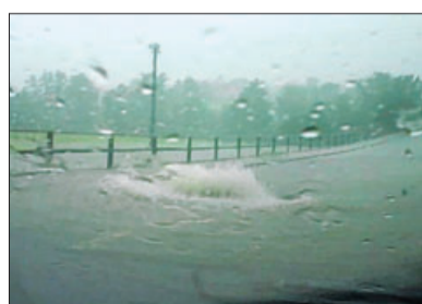
In Großaltdorf wurde ein Kanaldeckel aus der Verankerung gepresst. Foto: jj
